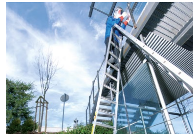
Esempio pratico - Il montaggio finale di una ringhiera è un tipico processo di saldatura TIG. Ma nella tromba delle scale non c'è ancora un collegamento elettrico. Quindi dovete disporre di un generatore o collegare in modo semplice la vostra saldatrice di Lorch alla batteria. Problema risolto!
