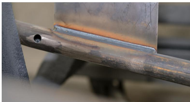
Le piastre d'acciaio con uno spessore compreso tra 1,0 e 1,6 millimetri vengono saldate al telaio base. Il processo di saldatura SpeedCold di Lorch applica solo l'energia esattamente necessaria.
