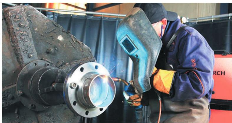
Luis Braga soude la passe de fond de la tubulure du tuyau avec un poste S-SpeedPulse de Lorch avec le procédé SpeedRoot de Lorch. La passe terminale est soudée avec SpeedPulse de Lorch.
