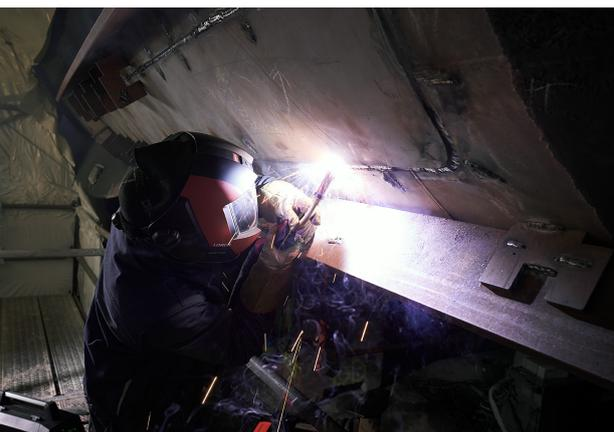
Enorme Blechstärken, enge Verhältnisse und schweißen in Zwangslage: die Arbeit auf der Werft verlangt Stromquelle und Schweißern einiges ab. Eine Herausforderung, die die MicorMIG Pulse mit Bravour besteht.
