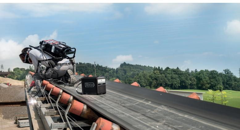
Durch die hochmoderne Invertertechnologie besitzt die MicorStick optimale Schweißeigenschaften. Ein automatischer Hotstart sorgt für eine perfekte Zündung und das Anti-Stick-System verhindert zuverlässig ein Festkleben der Elektrode.
