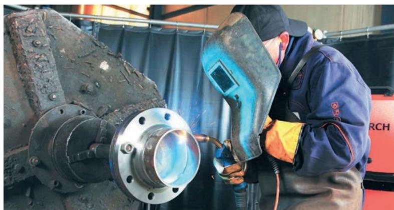
Luis Braga schweißt mit einer Lorch S-SpeedPulse-Anlage die Wurzellage des Rohrstützens mit dem SpeedRoot-Verfahren von Lorch. Die Decklage wird mit Lorch SpeedPulse geschweißt.
